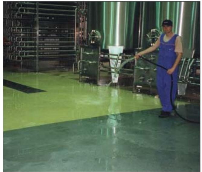
aplica con un espesor de 4-6 mm y se puede suministrar en diferentes combinaciones multicolores. El mortero se acaba mecánicamente y es fácil de limpiar.
